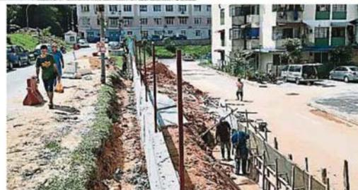
Glen Court组屋C及D座沟渠壁坍塌后，修复工作优先处理，工程如火如荼进行。
