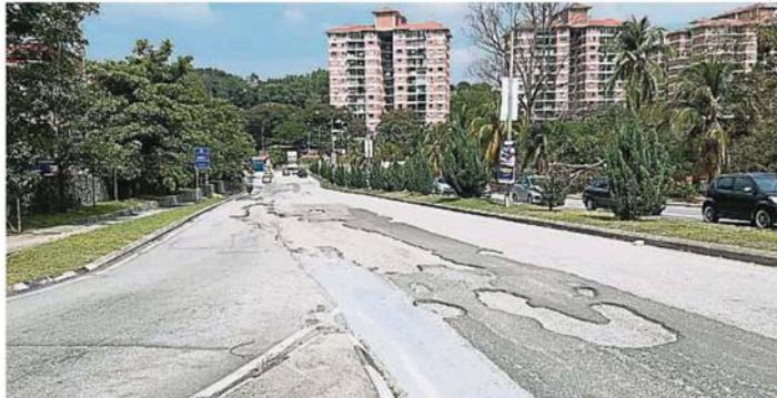
经常受到大量雨水冲刷造成损坏的双溪龙路，将采用石胶泥沥青混凝土技术进行重铺。
